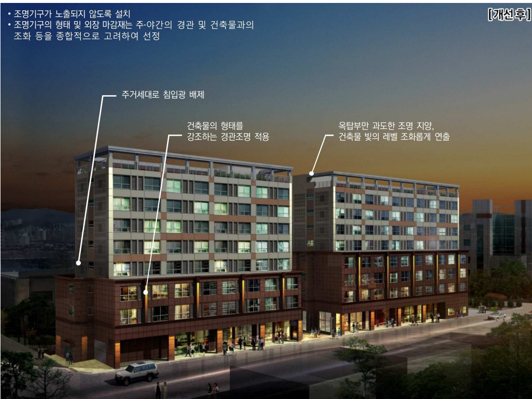
[그림 4-5] 〈공동주택〉 야간경관 개선 후
