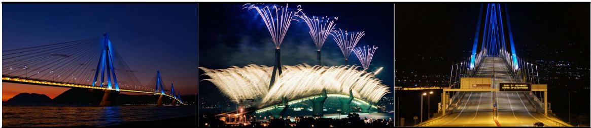
[그림 2-35] Rion-Antirion Bridge(출처 : https://www.gefyra.gr/ )
