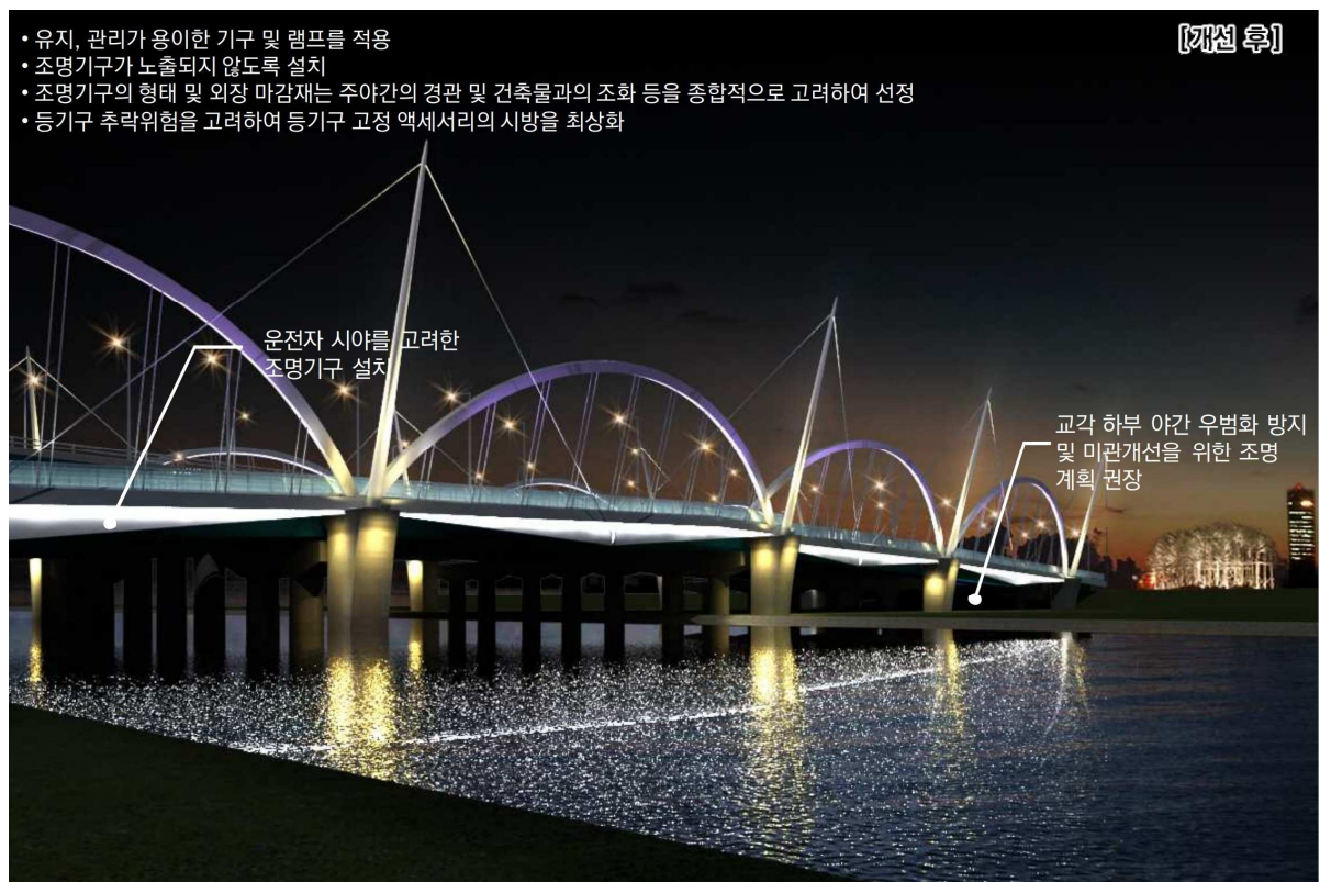
[그림 4-21] 〈토목구조물〉 야간경관 개선 후
