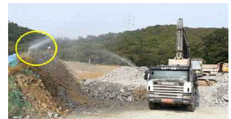
실기 내리기 작업구간 스프링클러 설치
