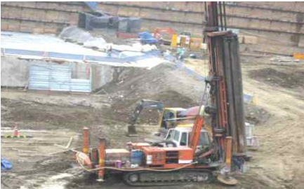
천공기 에어매트 설치 전
