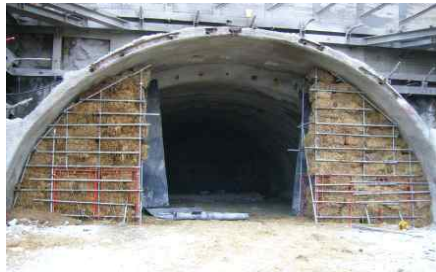
3중 방음문 설치 고무벨트 - 빗집방음벽 - 흡음스펀지 [소음 67dB(A)]
