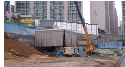
암 파쇄 시 방진덮개 설치
