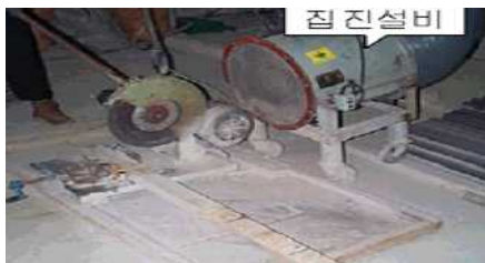
이동식 집진설비 설치
