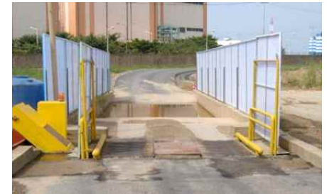
수조식+자동식 세륜시설 설치
