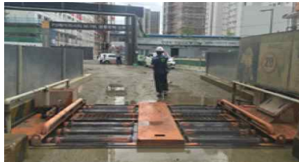
자동식 세륜시설 설치
