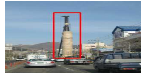
천공기 방진망 설치
