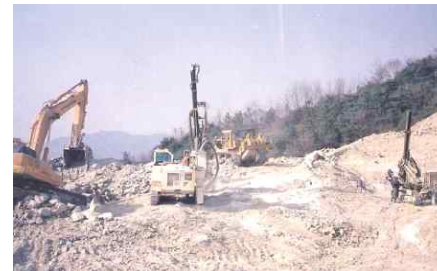
암파쇄구간 브레이커 사용 [20m 이격거리 소음도100dB(A)]
