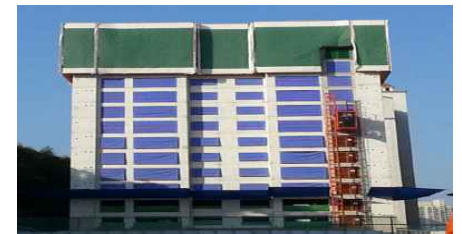
비산먼지 발생 작업 층 방진망 설치
