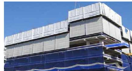
건물 외벽 방진조치
