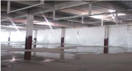
골조 뿔칠 작업 시 천막 방진망 설치
