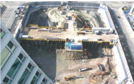
터파기 공사 소음차단커튼 설치 전
