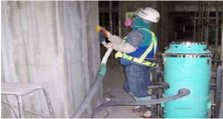
벽체 연마 작업 시 이동식 집진기 사용
