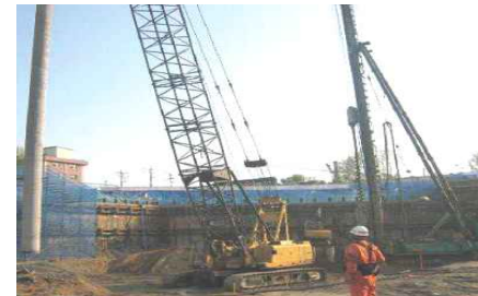
파일항타 작업(고무받침대 미사용)
