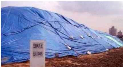
모래 및 토사 야적 방진덮개 설치
