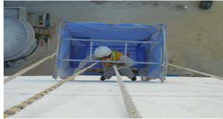
벽체 연마 작업 시 방진조치
