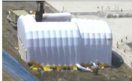
천공기 주변 에어매트 방음벽 설치
