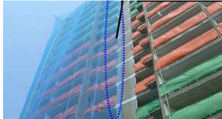
야외도장 작업 부위 방진망 설치
