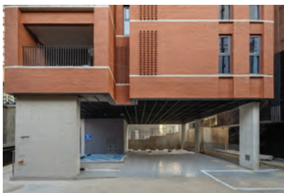
자연감시가 가능한 저층부 진입공간 및 주차공간 (한국건축문화대상_모아썬집)
