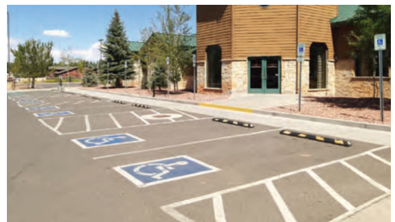
장애인전용주차구역 및 보행안전통로 설치
