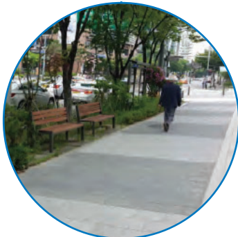
가로등, 전신주 등이 보행안전구역으로 돌출되지 않도록 설치
