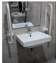
낙상방지 안전손잡이 설치
