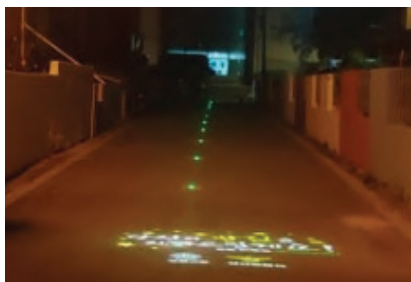
골목길 안전한 보행을 유도하는 솔라표지병 설치
