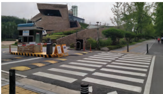
주차장 진출입구 고원식횡단보도 설치로 보행안전 확보
