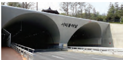
노출콘크리트 및 무광택 소재를 적용한 터널 진출입부
