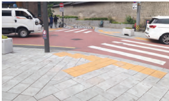
보행안전구역 시점부 점자블록 설치
