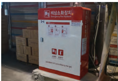
인천광역시 표준디자인의 옥외소화전 설치
