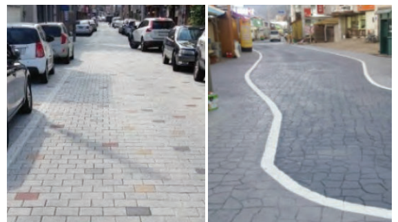
보도와 유사한 보행친화형 바닥재 및 무채색의 도막형 바닥재(스텝핑 기법)
