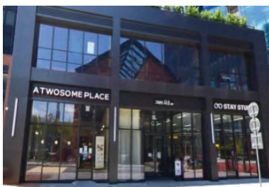
간판 교체 시 입면 손상을 최소화할 수 있는 간판 구조적 시스템 적용(입구부 상단 게시면 지정, Bar 고정 설치, 판류 고정 설치 순)
