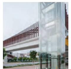
육교와 연결된 엘리베이터 설치
