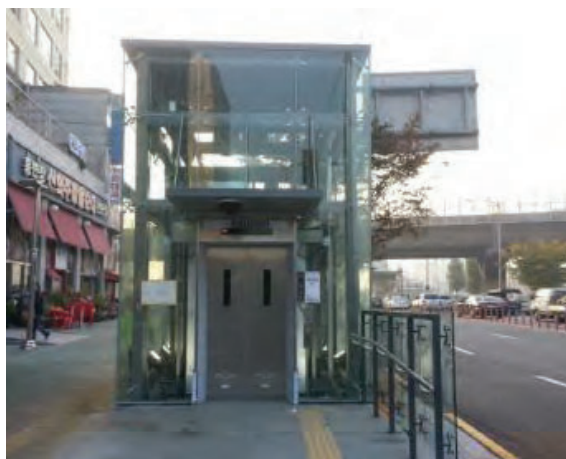
외부 보행환경에 간섭이 없도록 별도 설치된 지상 노출 엘리베이터
