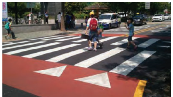
어린이보호구역의 고원식횡단보도 설치
