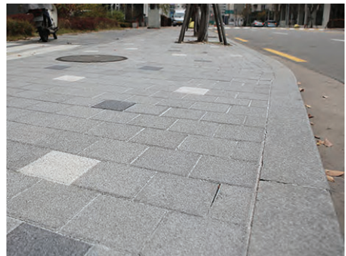
치밀한 보도블록 간 틈새 시공
