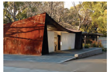
진입로 무단차의 경사로 설치
