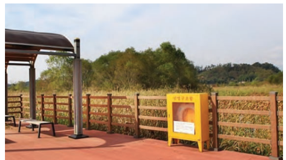
안전을 고려한 안전시설물 설치
