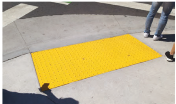
넓은 판형의 점자블록 설치
