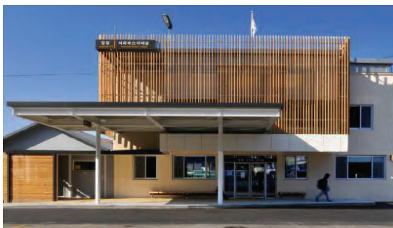
진입공간 등 상부 캐노피 설치
