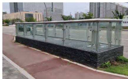
보행자 및 자전거 이용 동선을 단절시키지 않고 보행로 외곽부에 설치
