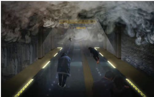
비상대피로 조명 설치
