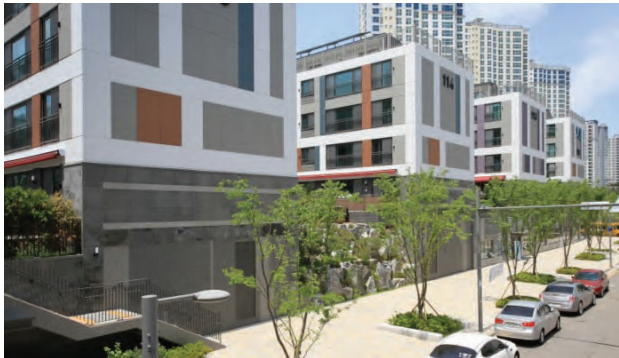
저층부에 무채색 계열 색채를 일관되게 적용하여 시설물 간의 통일성 확보 (한국건축문화대상_청라파크 자이 디테라스)
