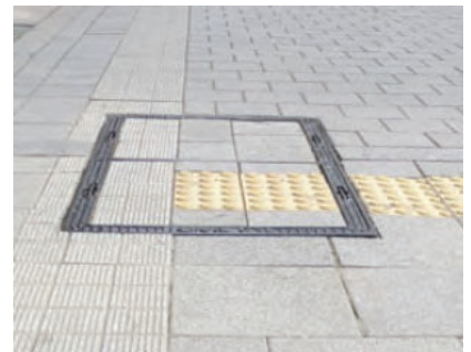
점자블록 등이 맨홀에 의해 단절되지 않도록 설치
