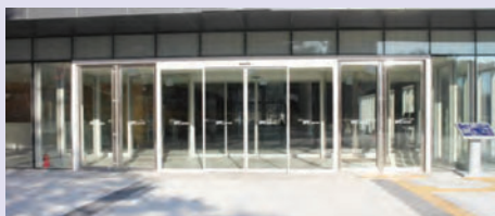
주출입구 자동 미닫이 출입문 설치
