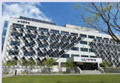
건물일체형 태양광시스템(BIPV)을 차양형태로 적용
